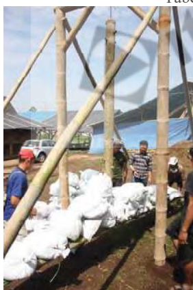
Gambar 14. Proses Pengujian Sambungan Bambu 2
