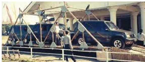
Gambar 3. Jembatan Bambu Sumber: Morisco (1996)
