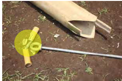
Gambar 12. Kerusakan pada Sambungan Bambu 1 Pasca Pengujian
