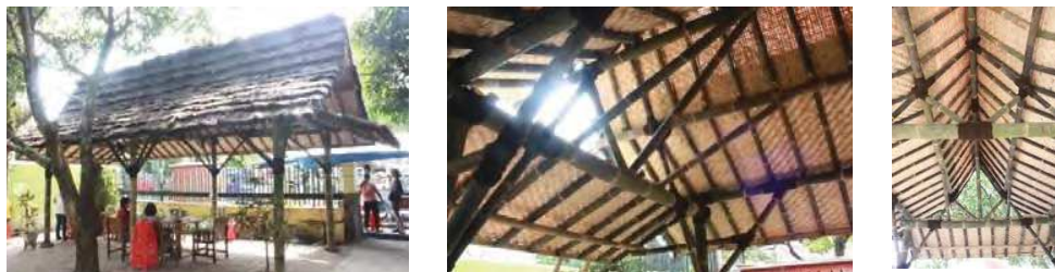
Gambar 1. Contoh bangunan bambu dengan sambungan pasak dan diikat tali ijuk
