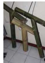
Gambar 7. Detail Sambungan 1
