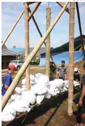
Gambar 14. Proses Pengujian Sambungan Bambu 2
