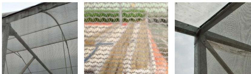
**Gambar 2. 4** Konstruksi Pipa Baja, Jaring Insect Net, dan Plastik UV
