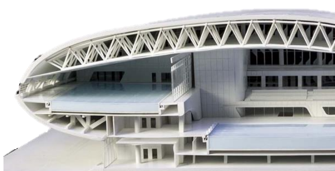
Gambar 2.21 Struktur Rangka Atap Aquatic Center Sumber: archidaily.com / diakses 26-02-2020
