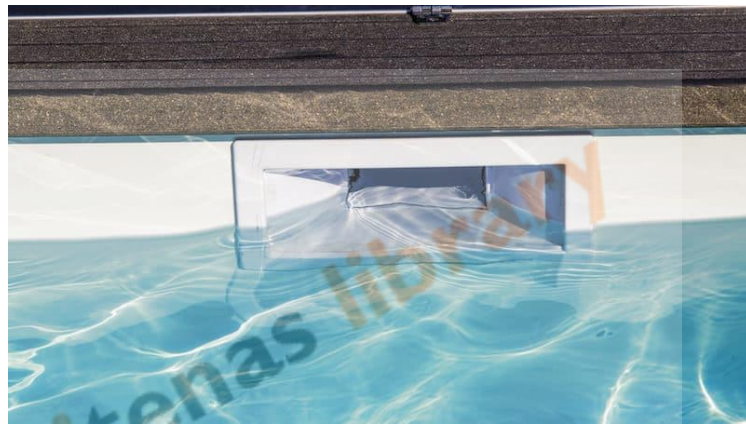
Gambar 2.9 Lubang skimmer pada kolam sistem skimmer
