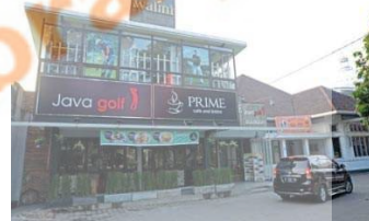
Gambar 9. Penambahan bangunan baru
