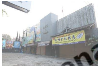
Gambar 8. Penutupan fasad bangunan lama
