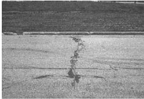
Gambar 2.5 Retak Memanjang dan Melintang
