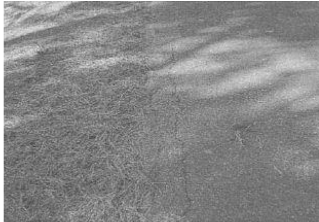
Gambar 2.4 Retak Pinggir
