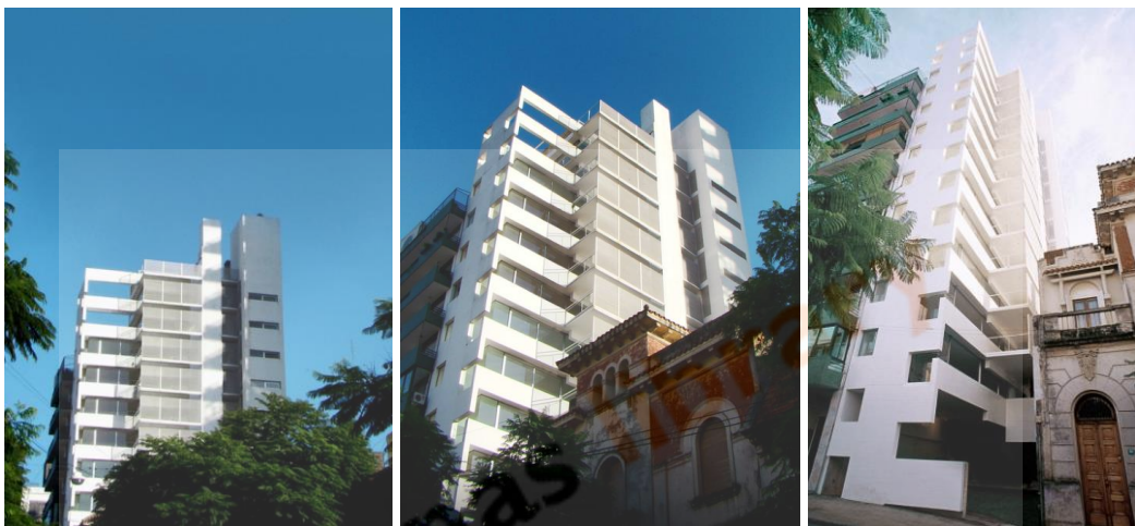
Gambar 2.6 Eksterior Altamira Building
