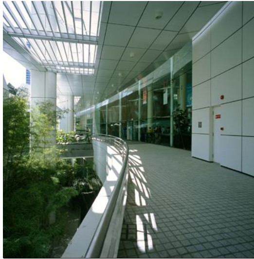
Gambar 2.8 Koridor di National Library Singapura yang berfungsi sebagai sunshading (Sumber: www. archute.com )
