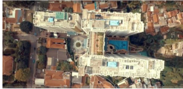
Gambar 2.2 Tampak Apartemen Parahyangan Residences
