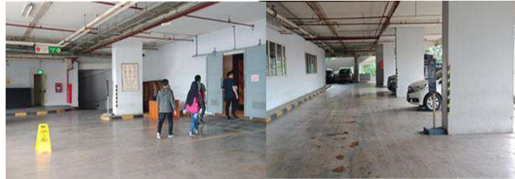
Gambar 2.65 Area Loading Dock Ballroom (Kiri) dan Parkir Mobil (Kanan)
