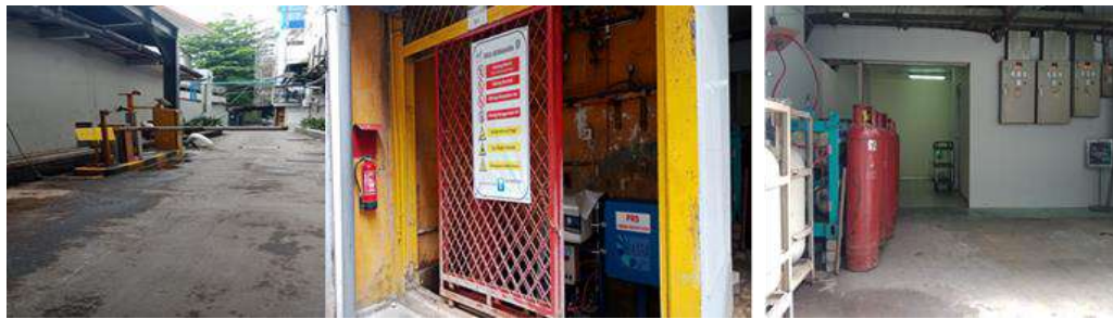
Gambar 2.59 Pintu Masuk Servis (Kiri), Ruang Gas (Tengah), dan Area Loading Dock (Kanan) (Sumber: Survey 22 Februari 2019)
