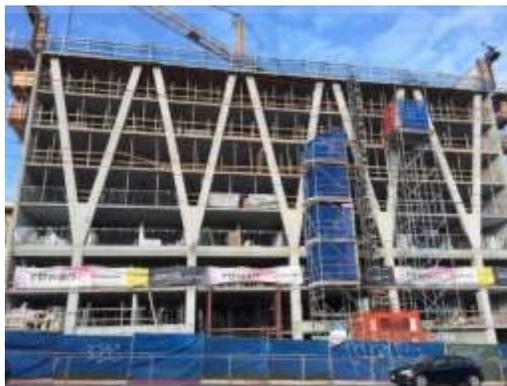
**Gambar 2.15.** Konstruksi Kolom V
