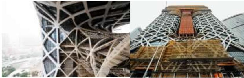
**Gambar 2.3.** Detail Struktur Eksoskeleton
