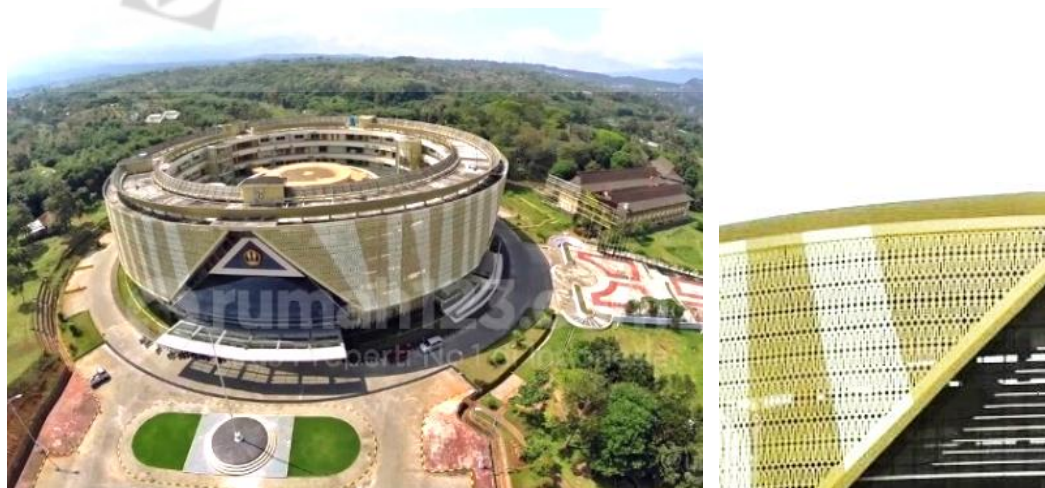
Gambar 2. 10 Detail Fasad Gedung Rektorat Universitas Padjadjaran
