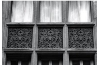
Gambar 2.6 Sprandel pada Roloson Row Houses
