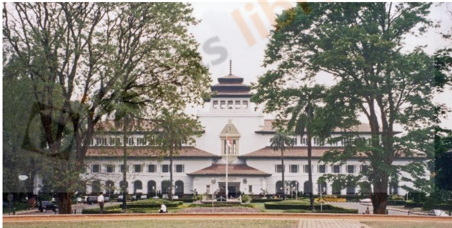
Gambar 2. 9 Tampak Depan Gedung Sate
