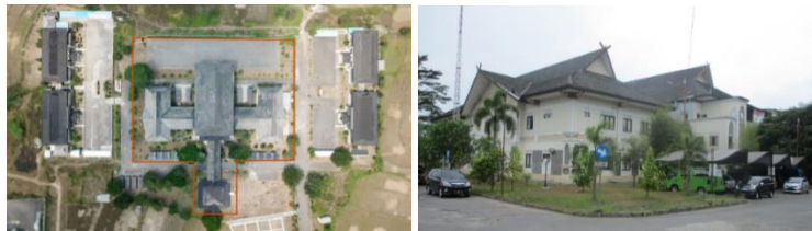
Gambar 2.1 Bangunan Dinas Sekretariat Daerah Kabupaten Sumedang
