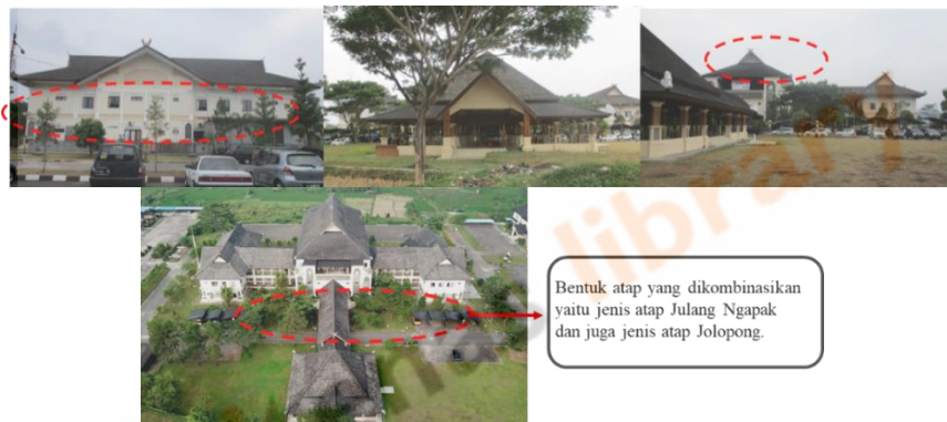
Gambar 2.2 Bangunan Dinas Sekretariat Daerah Kabupaten Sumedang
