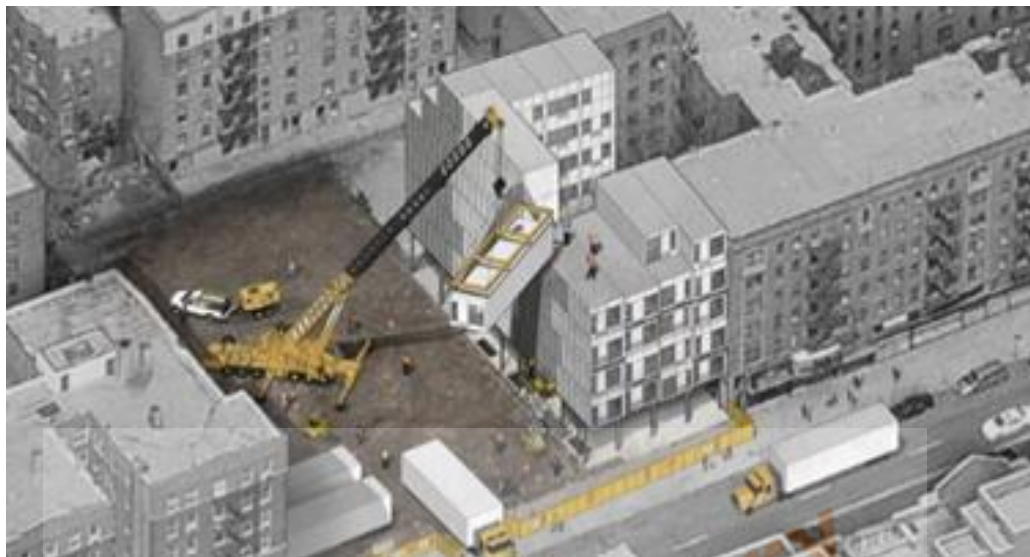
Gambar 2.10 Pembangunan Stack apartement
