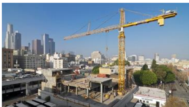
Gambar 2.12 pembangunan Star Apartement
