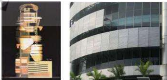
Gambar 2.17 Fasad bangunan Menara Mesiniaga (Sumber : http://www.solaripedia.com )
