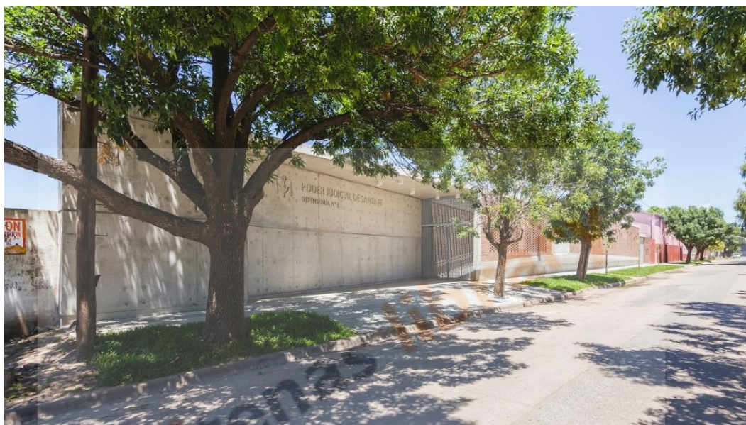
Gambar 2.7 Pintu Masuk Bangunan
