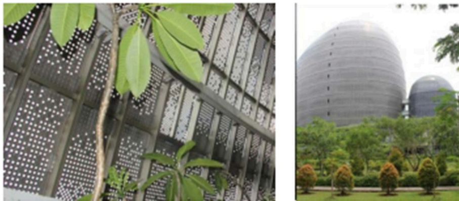
Gambar 2.3. Screen panel pada Student Center Mahasiswa UMN (kiri), Tampak keseluruhan bangunan Student Center Mahasiswa UMN (kanan)
