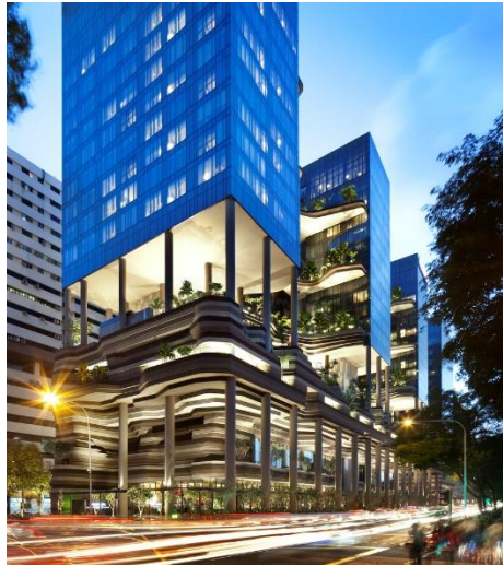
Gambar 2. 12 PARK ROYAL On Pickering (Sumber : https://www.archdaily.com Diakses tanggal 26 januari 2019 pukul 23.00)
