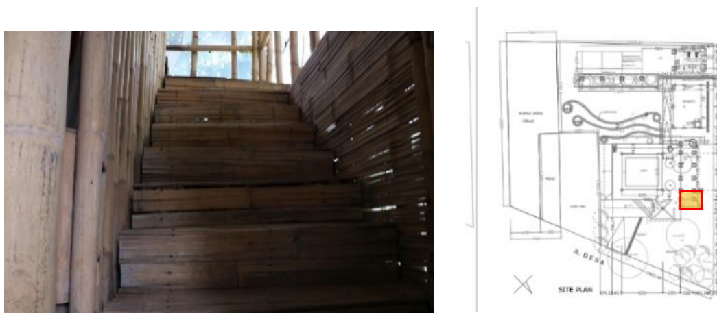
Gambar 7 Material Bilah Bambu Lantai Area Tangga Utama Studio Akanoma (Sumber: Data Studio Akanoma & Data Pribadi)
