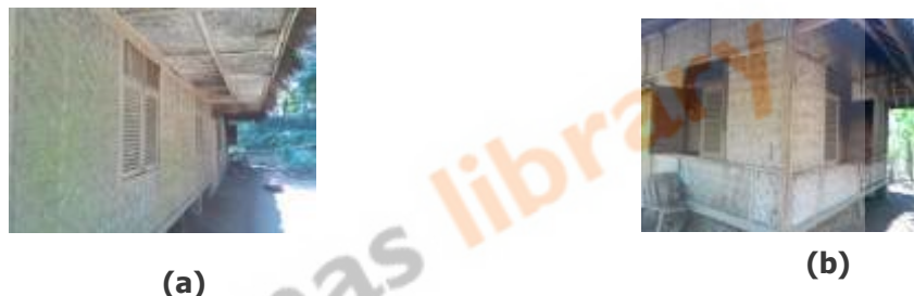
Gambar 2. (a) Anyaman dinding bambu dan (b) Bagian sudut dinding (Sumber : Data Pribadi)
