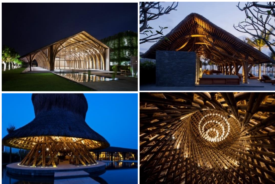
Gambar 2.4 Bangunan dengan material bambu sebagai struktur utama Sumber: https://www.archdaily.com/778812/naman-retreat-vo-trong-nghia-architects
