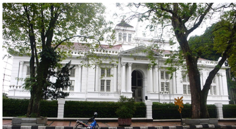
Gambar 2.1 Bangunan dengan Arsitektur Kolonial
