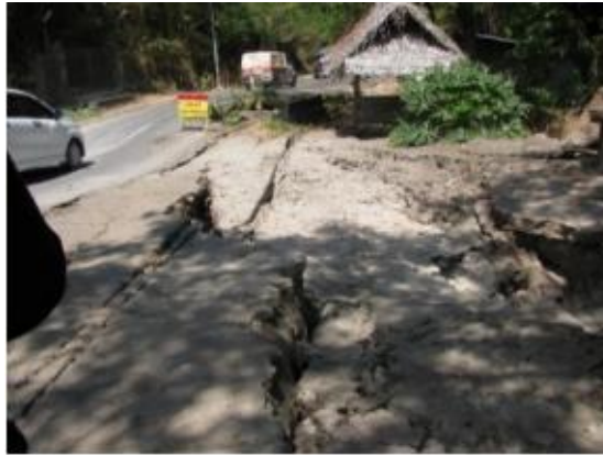
Gambar 2. 4 Lateral Spreading di Daerah Bayan, Lombok Utara
