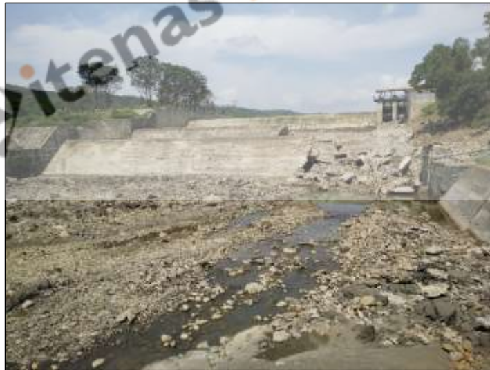
Gambar 1.1 Kerusakan Bendung Cipamingkis lama
