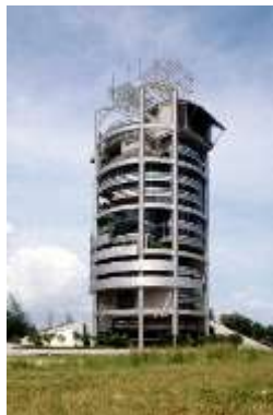
Gambar 2.20 Eksterior bangunan Menara Mesin Niaga (Sumber : http://www.solaripedia.com )
