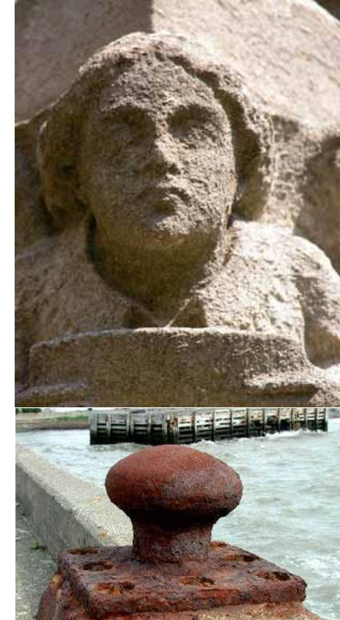
Bangunan (Kerusakan dan Korosif)
