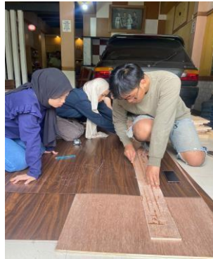
Gambar 17. Proses Pemotongan HPL
