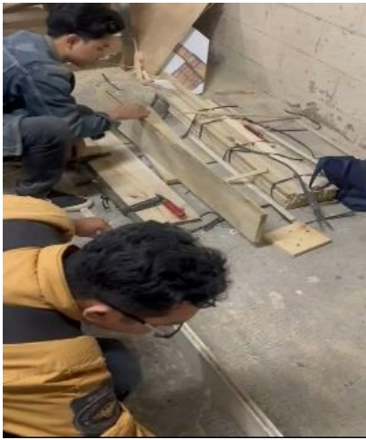
Gambar 10. Proses Pengeleman Papan dan Rangka
