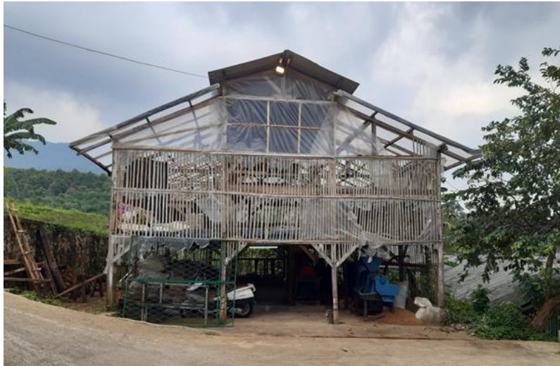
Gambar 1.11. Bangunan semi permanen pengolahan dan penjemuran kopi milik KTM
