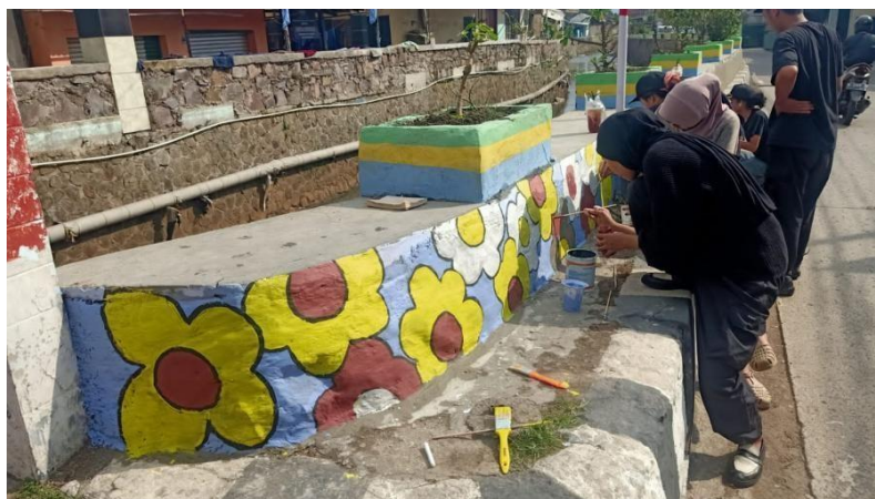
Gambar 7 Proses pengecatan pada area dinding
