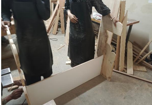
Gambar 21. Proses Perakitan Modul Source : Dokumentasi Pribadi
