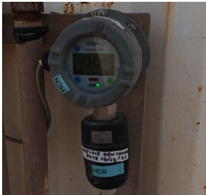
Gambar 3. 5 Alarm Pendeteksi Gas HCN
