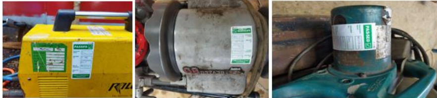
Gambar 3.19 Dokumentasi Inspeksi Terhadap Peralatan Listrik
