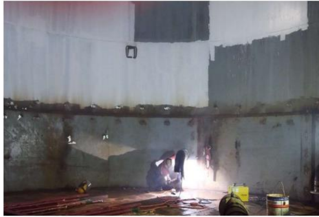
Gambar 3.17 Dokumentasi Pada Pengawasan Pekerjaan Ruang Terbatas
