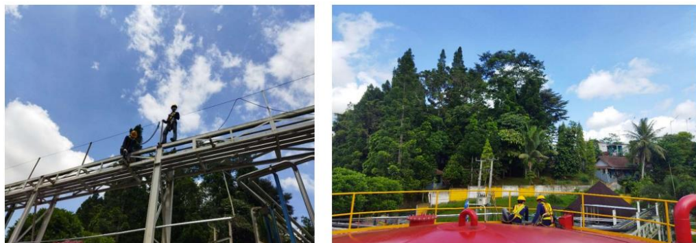
Gambar 3.16 Dokumentasi Pada Pengawasan Pekerjaan Ketinggian
