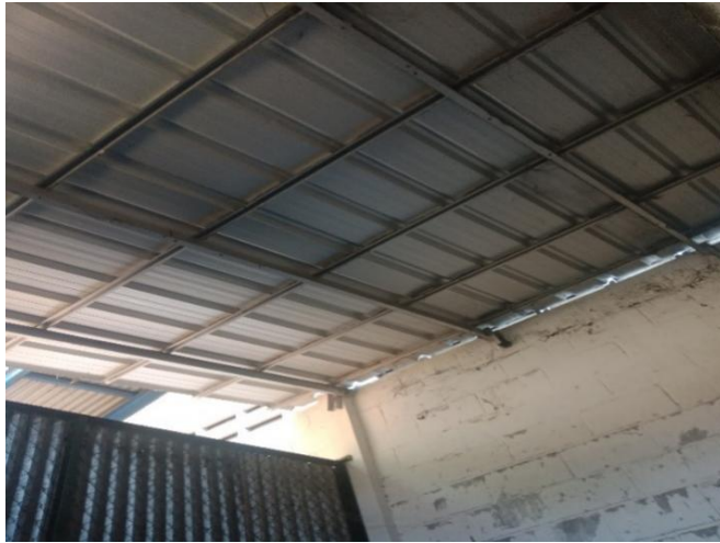
Gambar 4. 10. Bangunan Tanpa Plafon dan Berventilasi Kawat Sumber : Hasil Pengamatan, 2019
