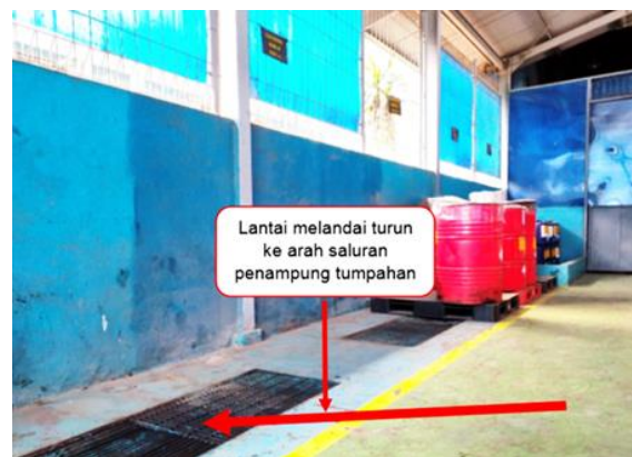
Gambar 4.6 Lantai dan Saluran di TPS LB3
