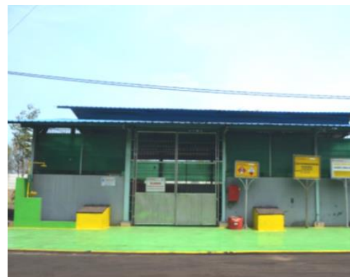
(b) Lantai Luar TPS LB3 Pelumas Bekas
