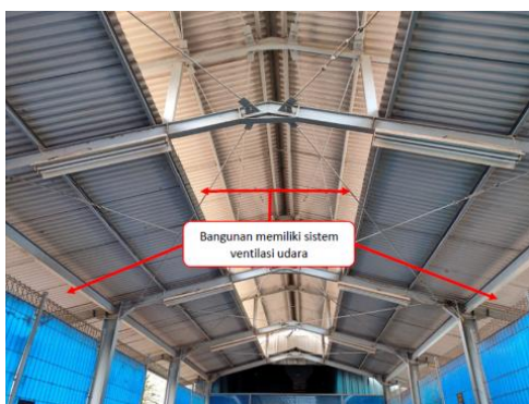
(a) Ventilasi Udara TPS LB3
