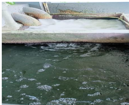
Gambar 4. 3 Unit Bak Pengumpul Air Baku IPAM Babakan
