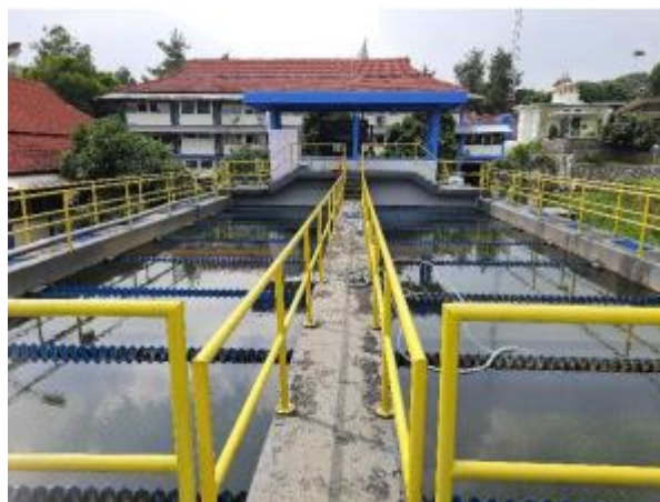
Gambar 4. 16 Unit Sedimentasi
