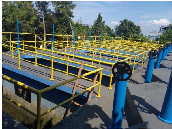
Gambar 4. 19 Unit Filtrasi
