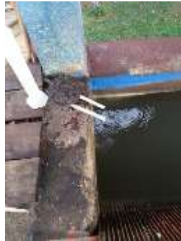
Gambar 4. 8 Pembubuhan PAC Liquid di Unit koagulasi
