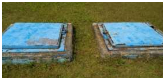
Gambar 4. 17 Akses Menuju Bak Reservoir
