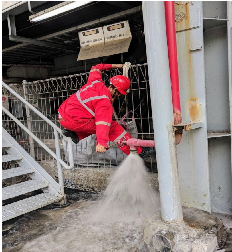
Dokumentasi Pengecekan Hydrant
