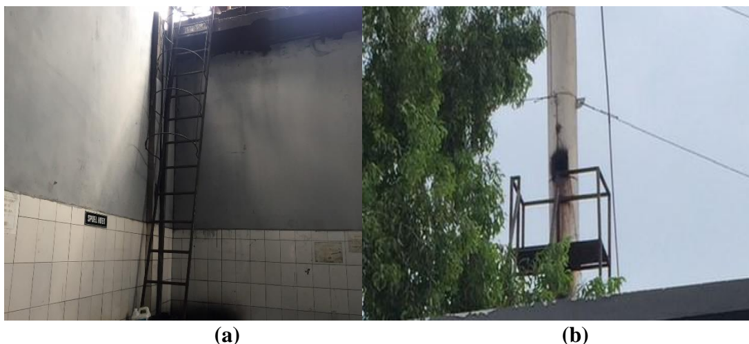
Gambar 4.10 (a) Tangga Menuju Lubang Pengambilan (b) Platform dan Lubang Pengambilan Contoh Emisi Insinerator
