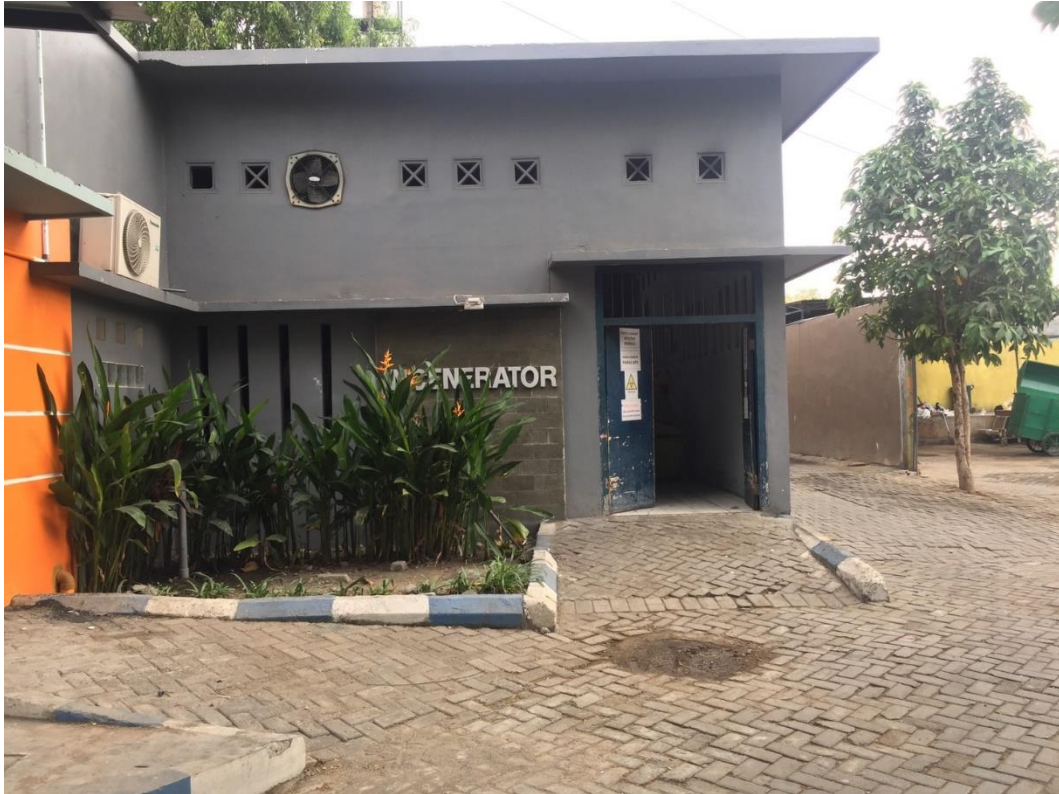
Gambar Ruangan Insinerator
