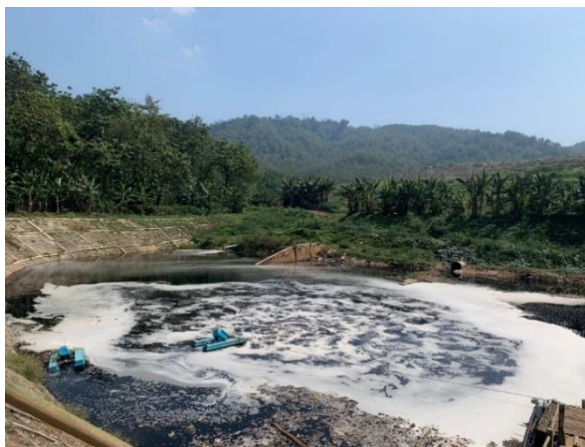
Gambar 4. 12 Kolam Stabilisasi di IPL TPA Sarimukti
