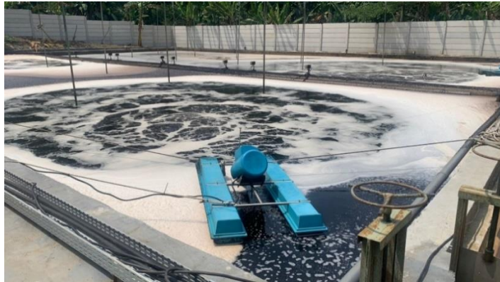
Gambar 4. 15 Kolam Aerobik di IPL TPA Sarimukti
