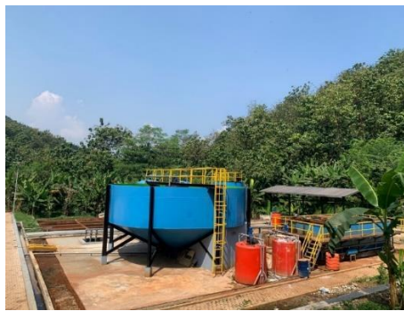
Gambar 4. 16 Clarifier Biologi di IPL TPA Sarimukti
