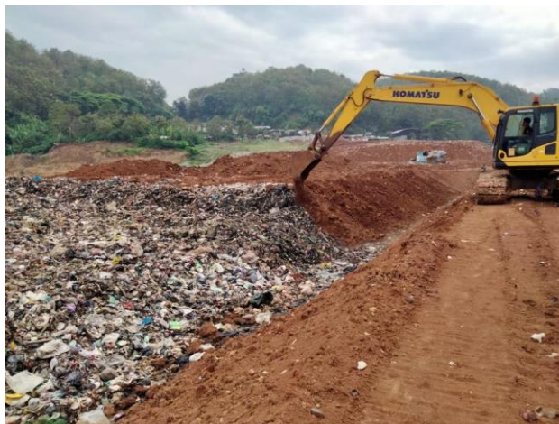
Gambar 4.9 Penyebaran Tanah Penutup
