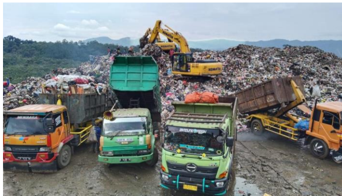
Gambar 4. 5 Penuangan Sampah di Lahan Kerja
