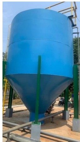
Gambar 4. 18 Thickener di IPL TPA Sarimukti
