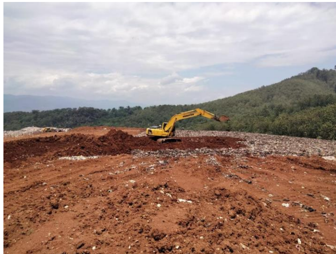
Gambar 4. 10 Pemadatan Tanah Penutup
