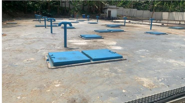
**Gambar 4.6** Kolam *Anaerobik* di IPL TPA Sarimukti
