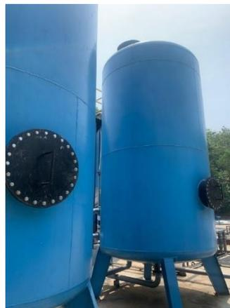
**Gambar 4.12** *Sand filter* dan *Carbon Filter* di IPL TPA Sarimukti
