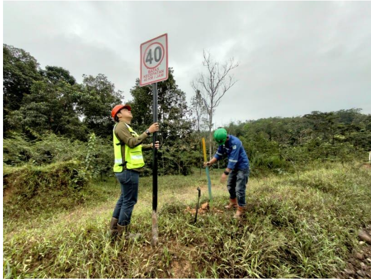
Gambar 1 Memasang Rambu di jalan angkut
