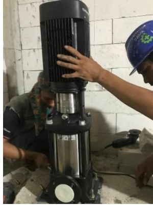
Gambar 5. 20 Pemasangan Pompa Pada Proyek Pembangunan Gedung Kantor DPRD Provinsi Jawa Tengah
