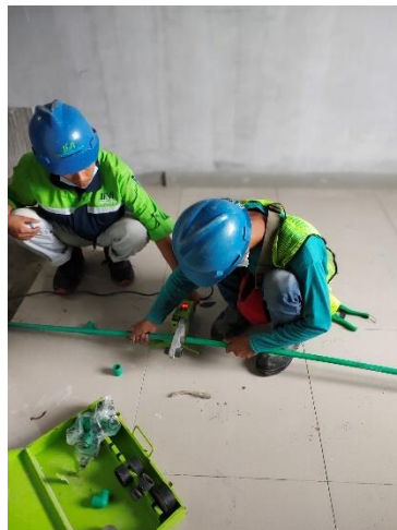
Gambar 5. 6 Pemasangan Pipa Air Bersih Pipa PPR
