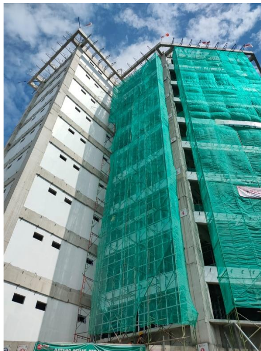
Gambar 4. 1 Proyek Pembangunan gedung DPRD Provinsi Jawa Tengah
