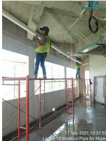
Gambar 5. 18 Pemasangan Pipa Air Hujan Pada Proyek Pembangunan Gedung Kantor DPRD Provinsi Jawa Tengah
