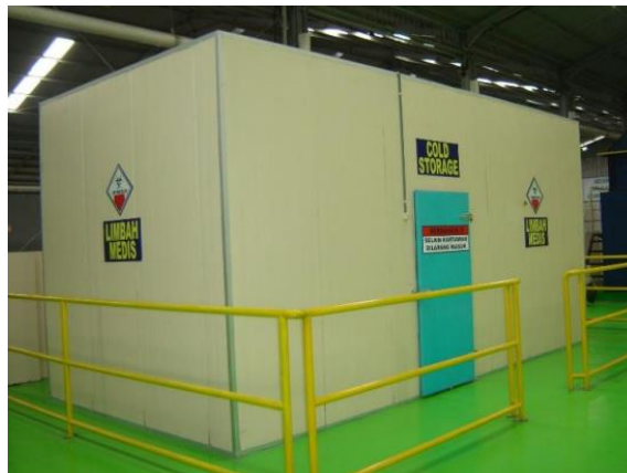
Gambar 3. 3 Contoh Ruang Pendingin untuk Penyimpanan Limbah B3 berupa Limbah Infeksius, Benda Tajam, dan/atau Patologis dalam Waktu lebih dari 48 jam sejak Limbah B3 Dihasilkan
