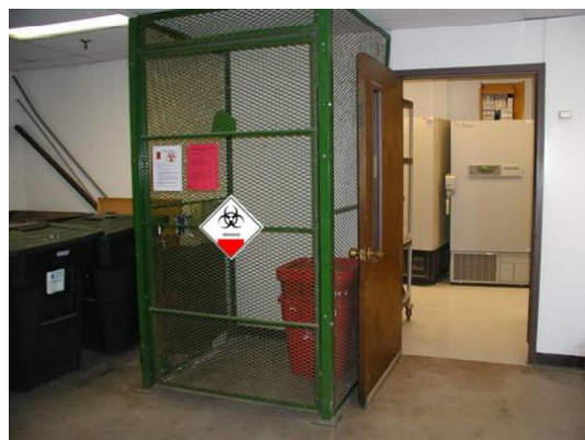
Gambar 3. 2 Contoh Fasilitas Penyimpanan Lim bag B3 dari Fasilitas Pelayanan Kesehatan dalam Ruangan yang Dilengkapi dengan Pembatas Akses (kerangkeng)
