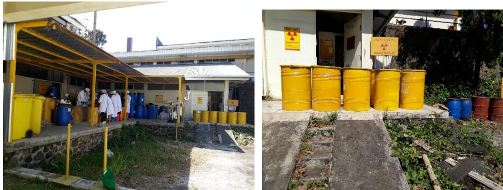
Gambar 4.8 Persiapan Wadah Limbah Radioaktif
