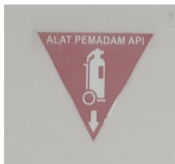
Gambar 4.24 Tanda Pemasangan Alat Pemadam Api Ringan (Sumber: Hasil Dokumentasi, 2019)
