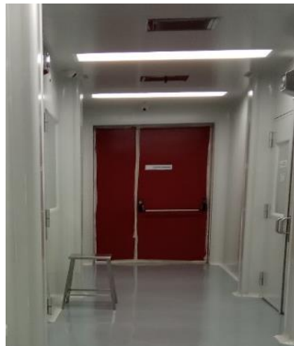
Gambar 4.31 Pintu Eksit Unit Produksi dan Pengemasan Non Steril (Sumber: Hasil Dokumentasi, 2019)
